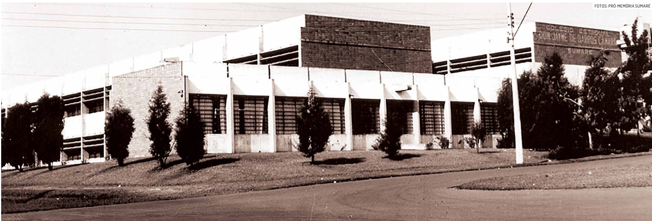
Prédio da Escola Dom Jayme de B. Câmara e Unidade Regional de Ensino
