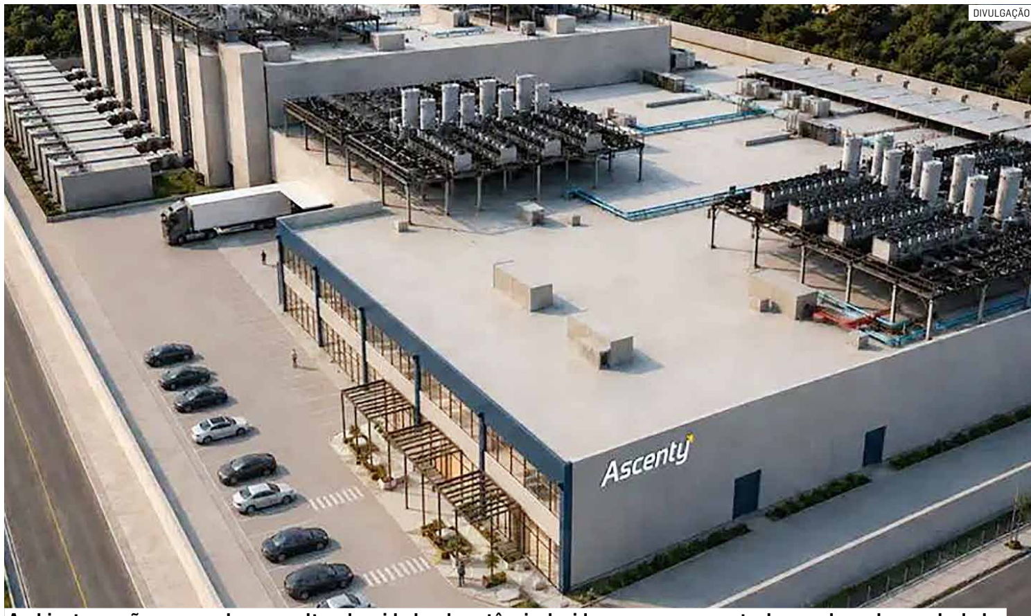
Ambientes serão preparados para altas densidades de potência devido ao processamento de grandes volumes de dados
