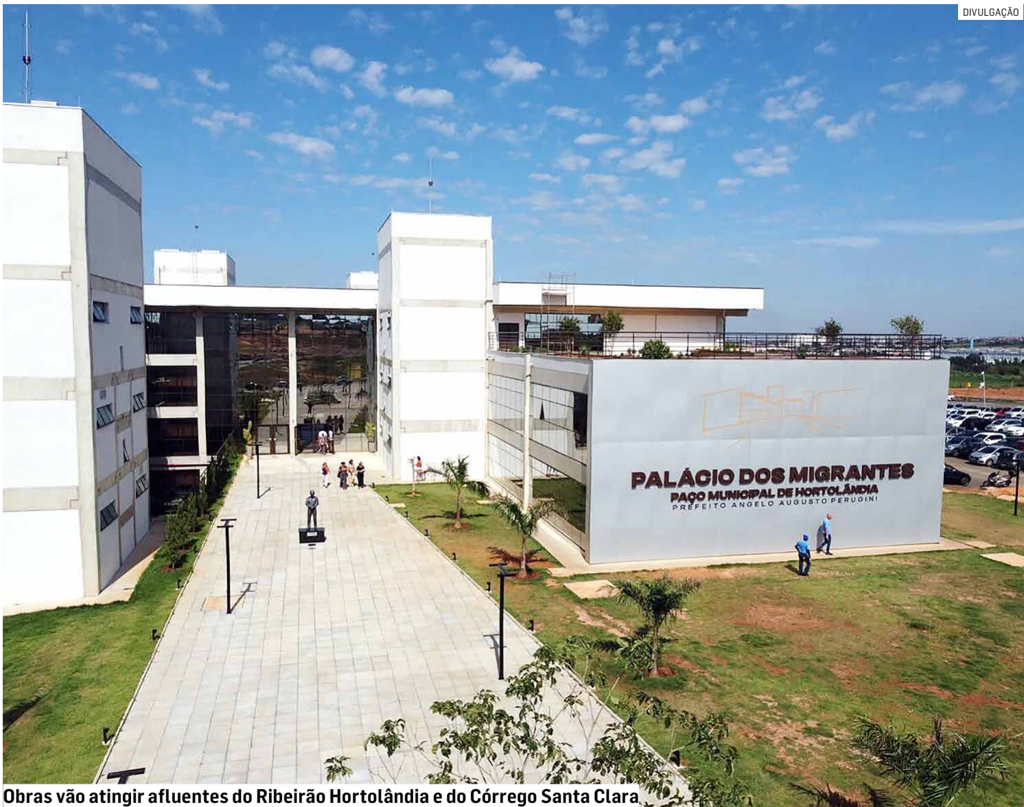
Obras vão atingir afluentes do Ribeirão Hortolândia e do Córrego Santa Clara
