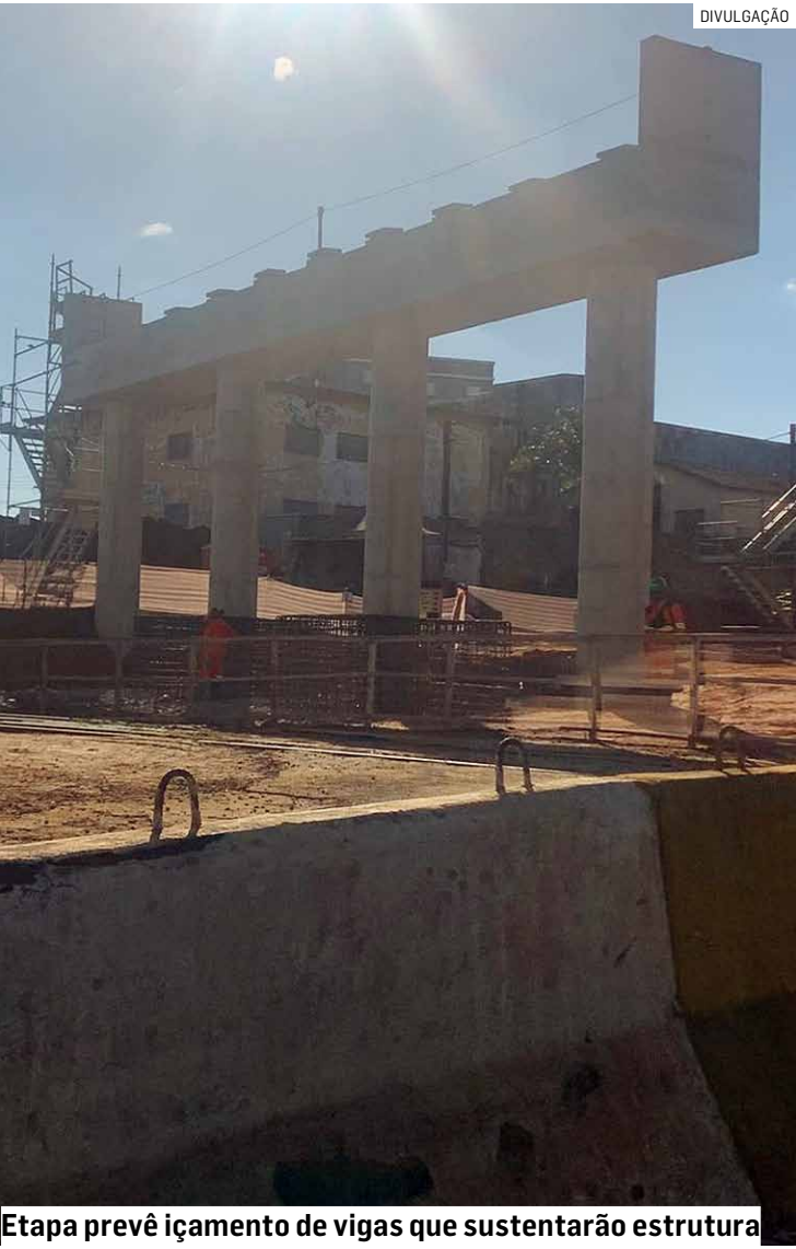
Etapa prevê içamento de vigas que sustentarão estrutura
