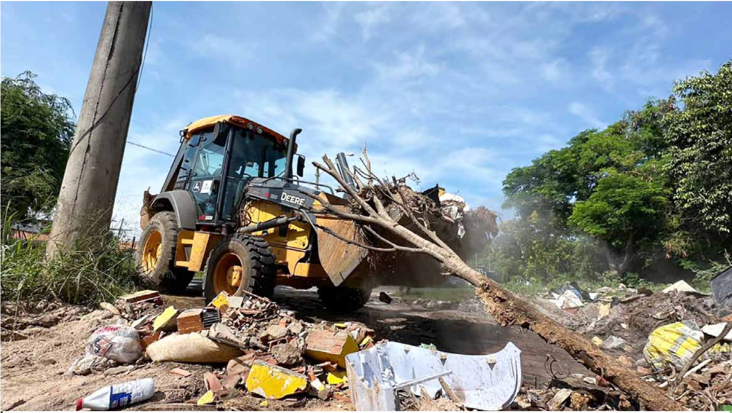
Toneladas de entulho foram removidas durante operações emergenciais, devolvendo dignidade e segurança aos moradores.
