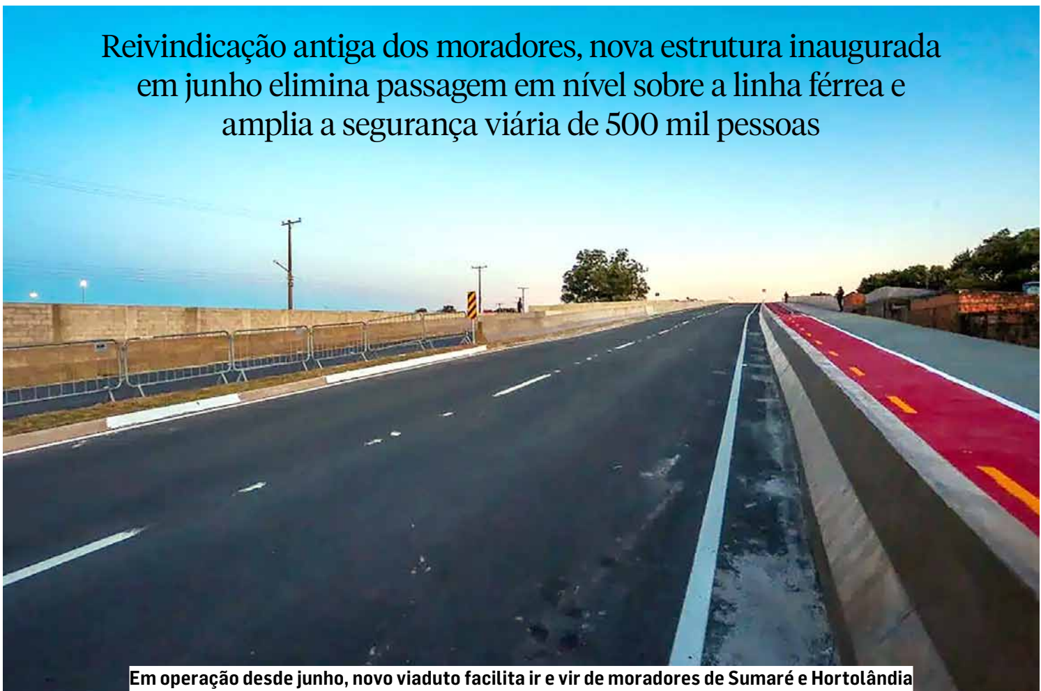
Em operação desde junho, novo viaduto facilita ir e vir de moradores de Sumaré e Hortolândia
