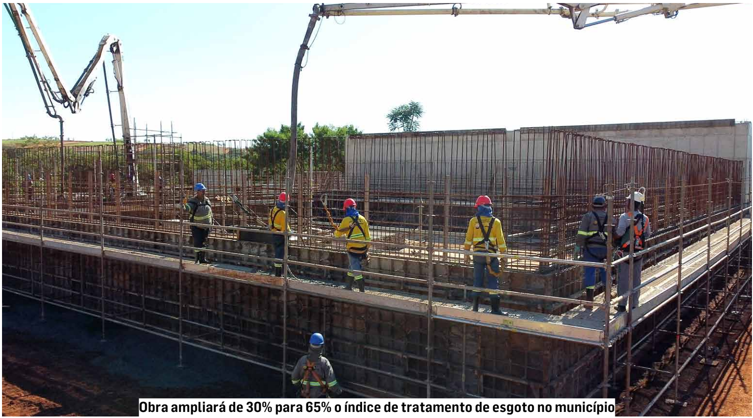
Obra ampliará de 30% para 65% o índice de tratamento de esgoto no município
