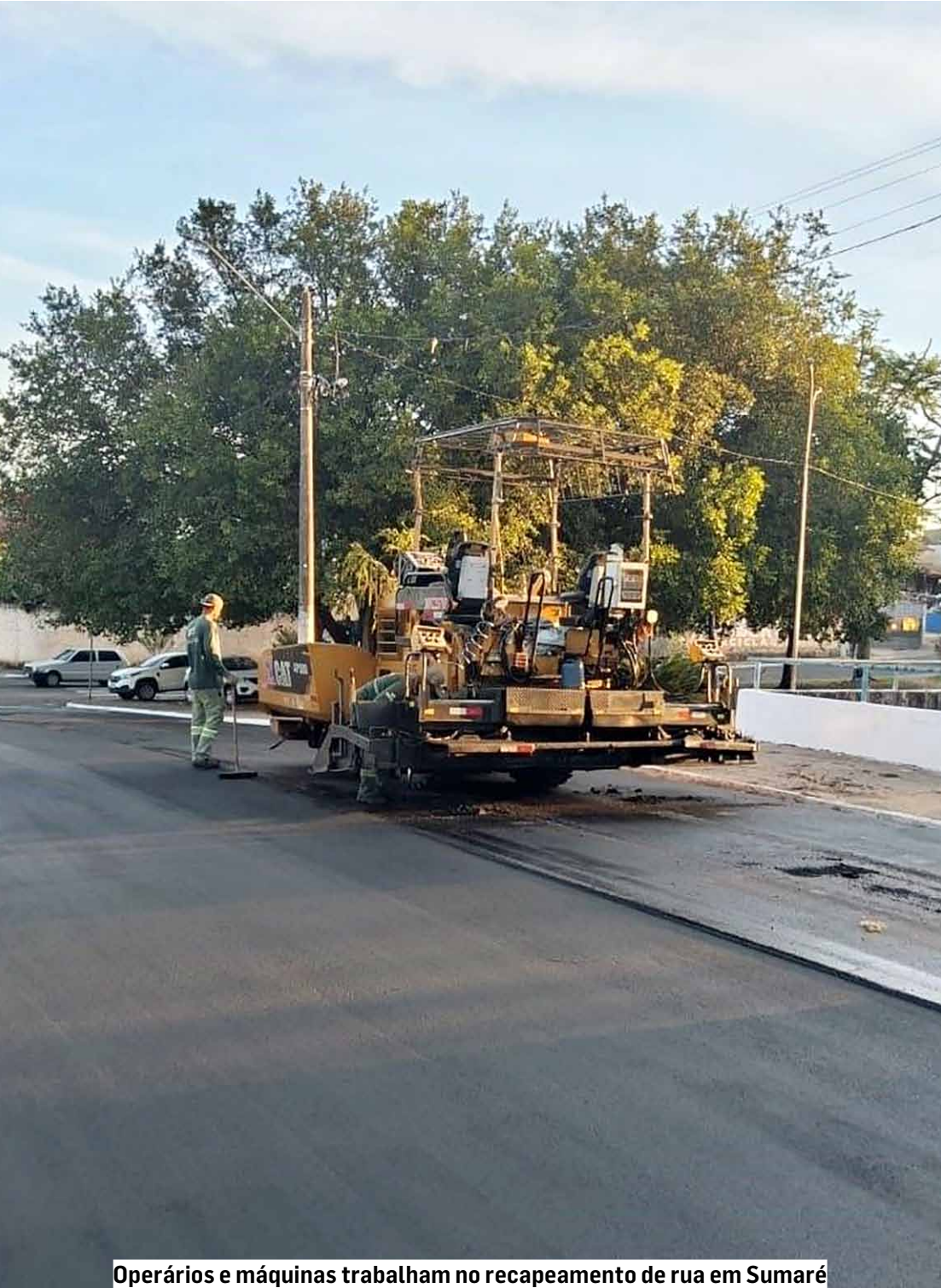
Operários e máquinas trabalham no recapeamento de rua em Sumaré
