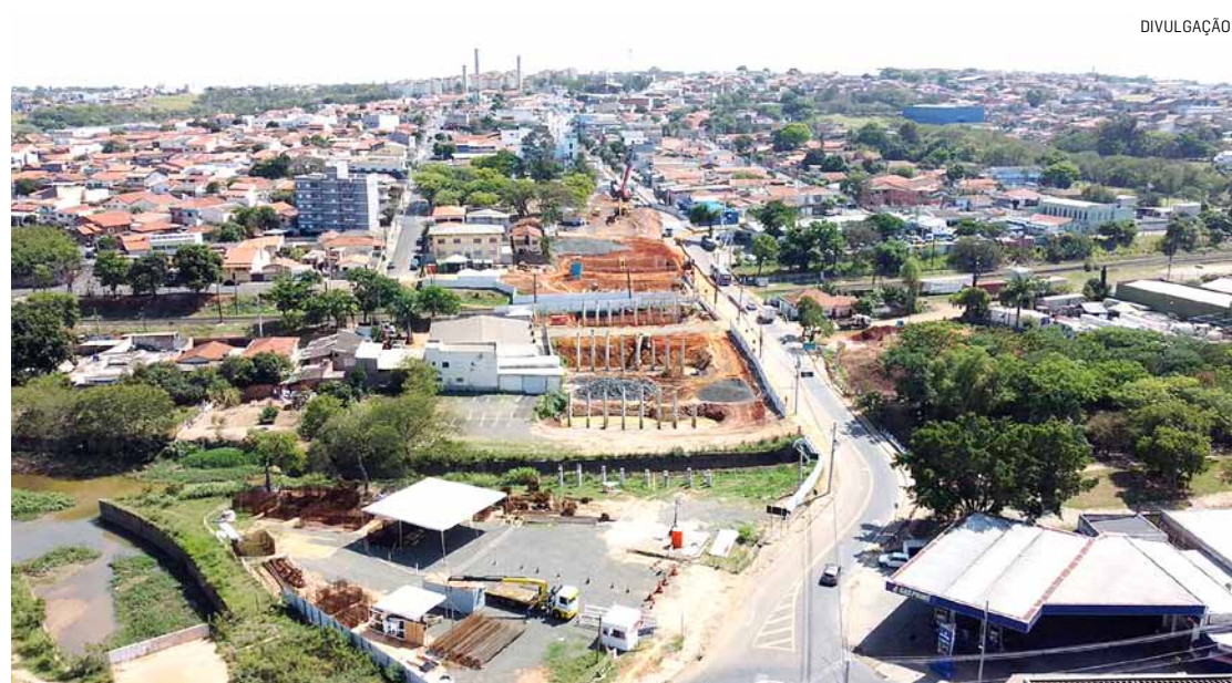
Após a fabricação das vigas, que demora entre dois e três meses, serão colocados os pilares
