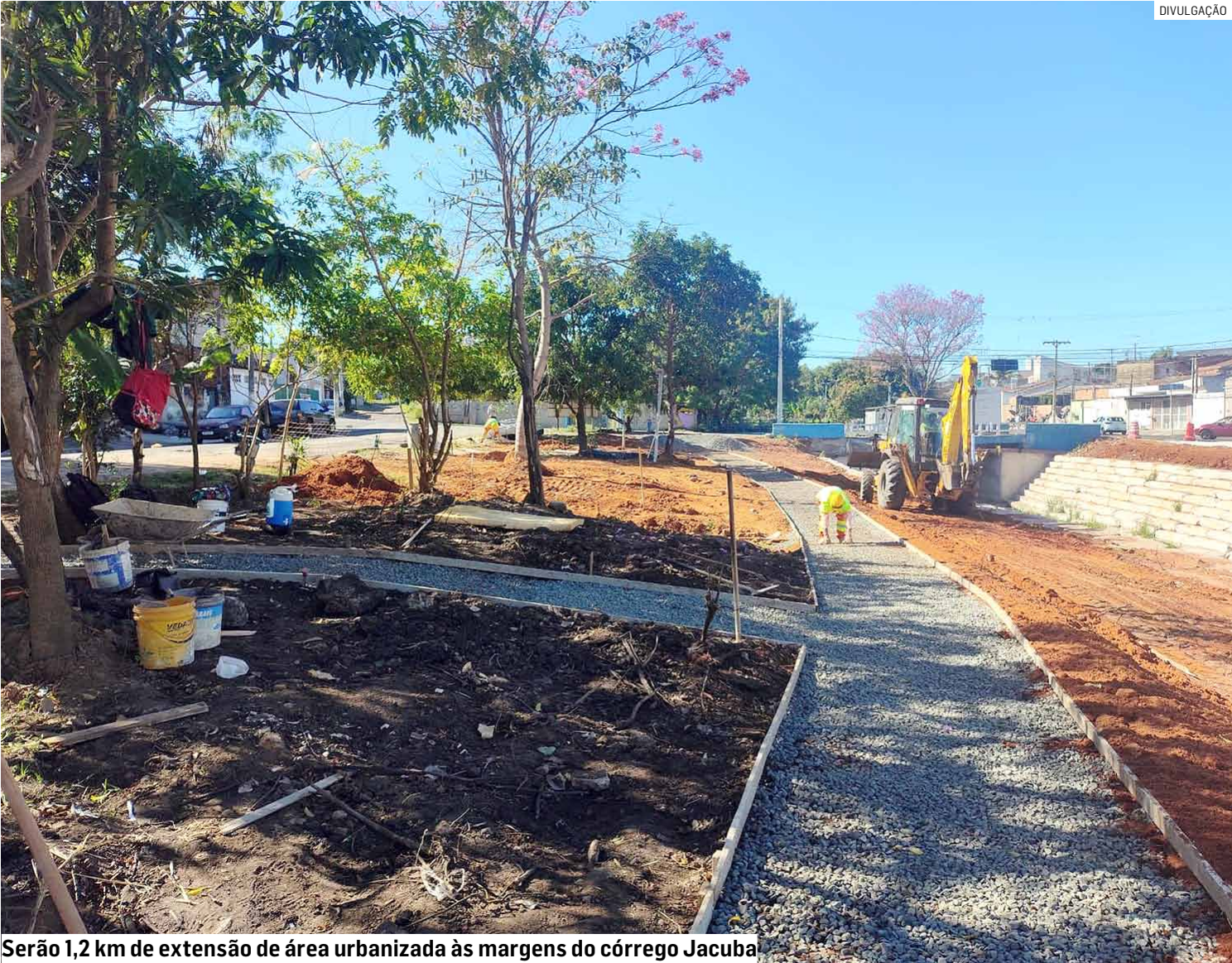
Serão 1,2 km de extensão de área urbanizada às margens do córrego Jacuba
