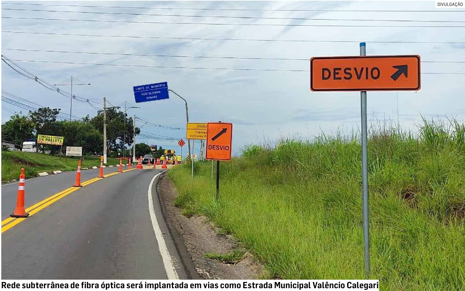
Rede subterrânea de fibra óptica será implantada em vias como Estrada Municipal Valêncio Calegari
