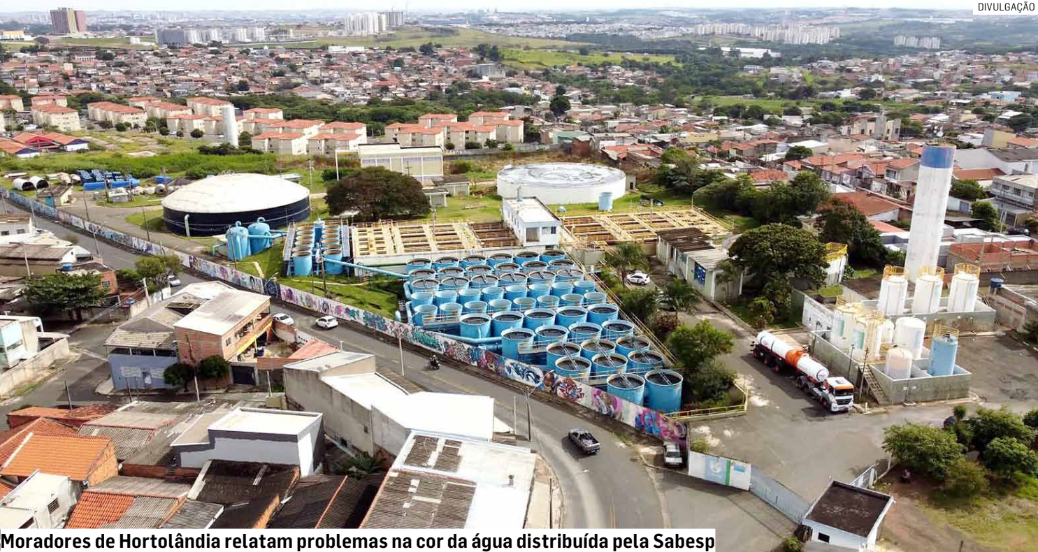
Moradores de Hortolândia relatam problemas na cor da água distribuída pela Sabesp
