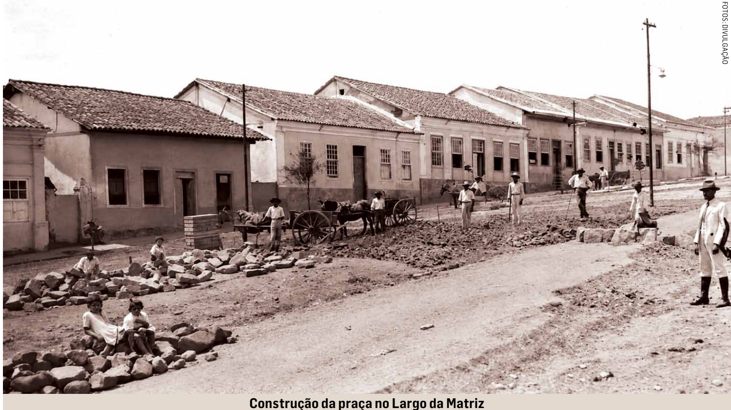
Construção da praça no Largo da Matriz
