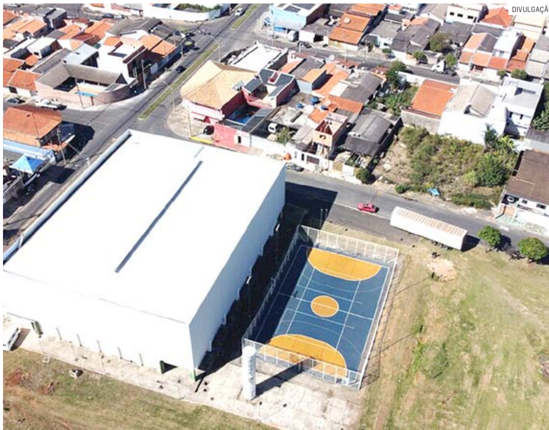
Entrega do complexo esportivo acontecerá na avenida Carlos Basso, no Residencial Bordon
