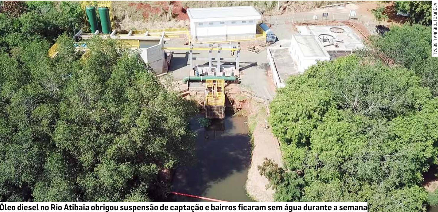
Óleo diesel no Rio Atibaia obrigou suspensão de captação e bairros ficaram sem água durante a semana
