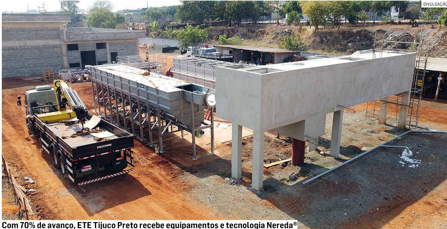
Com 70% de avanço, ETE Tijuco Preto recebe equipamentos e tecnologia Nereda®
