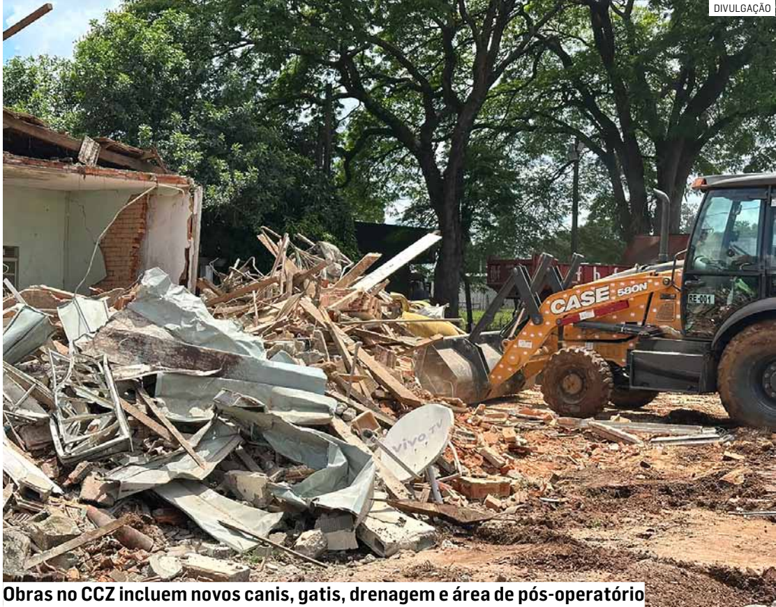
Obras no CCZ incluem novos canis, gatis, drenagem e área de pós-operatório
