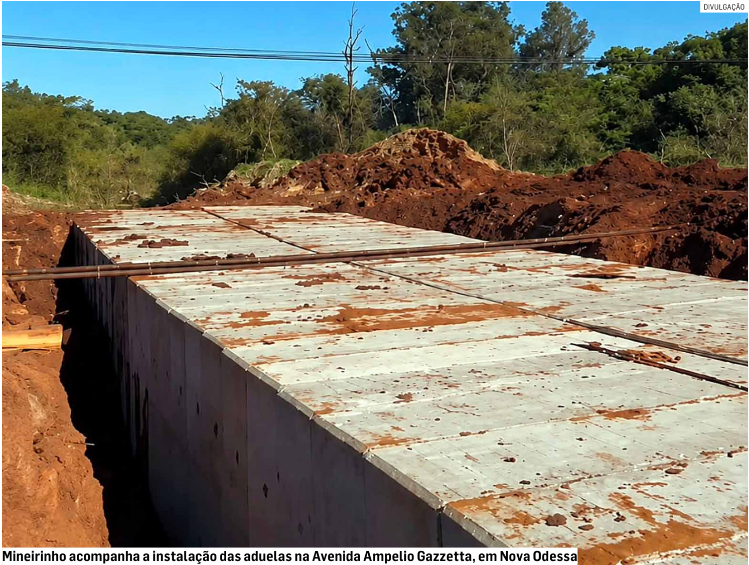
Mineirinho acompanha a instalação das aduelas na Avenida Ampelio Gazzetta, em Nova Odessa
