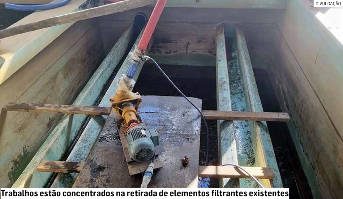
Trabalhos estão concentrados na retirada de elementos filtrantes existentes
