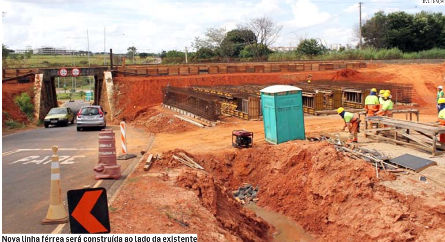
Nova linha férrea será construída ao lado da existente
