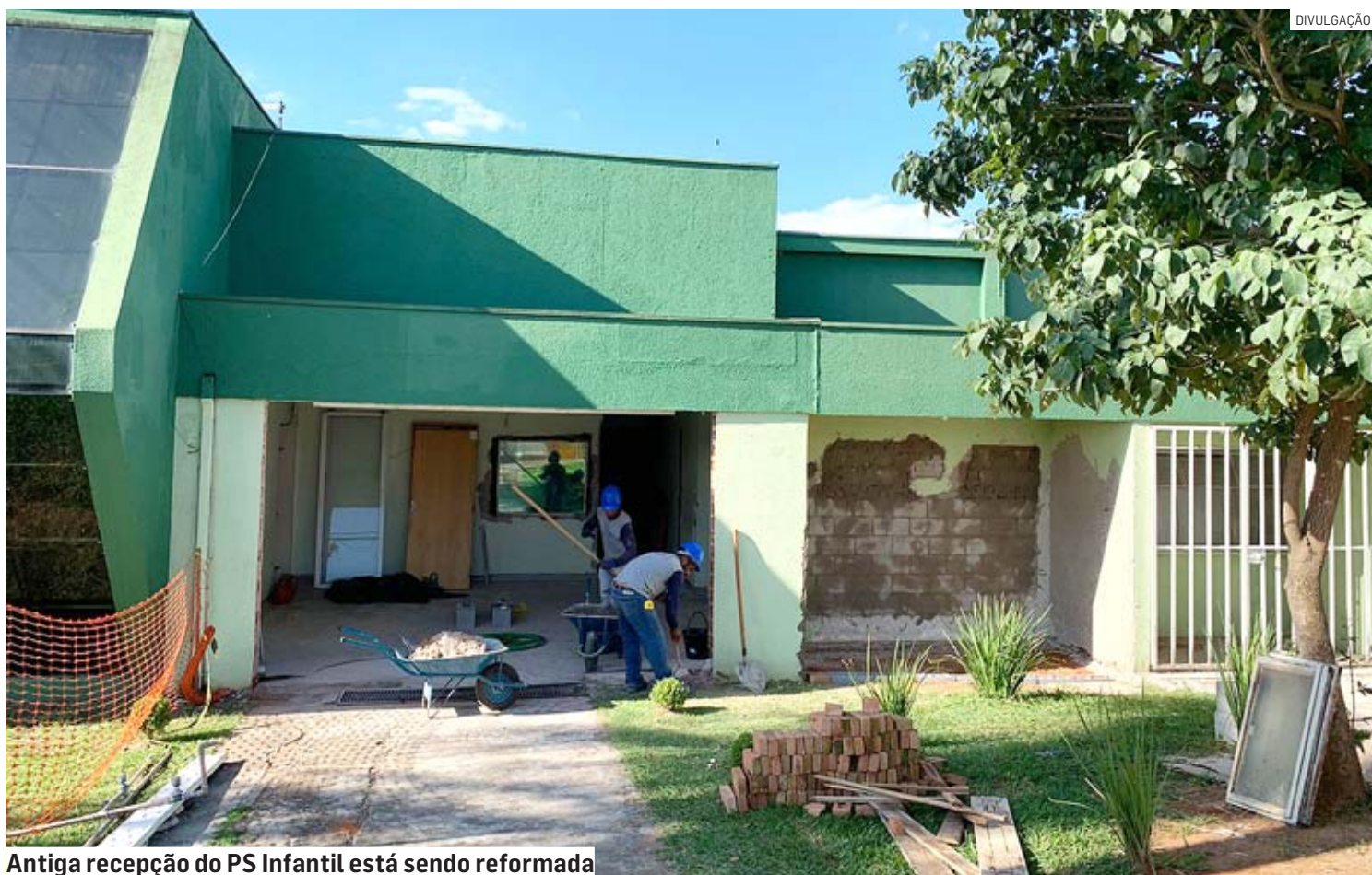
Antiga recepção do PS Infantil está sendo reformada
