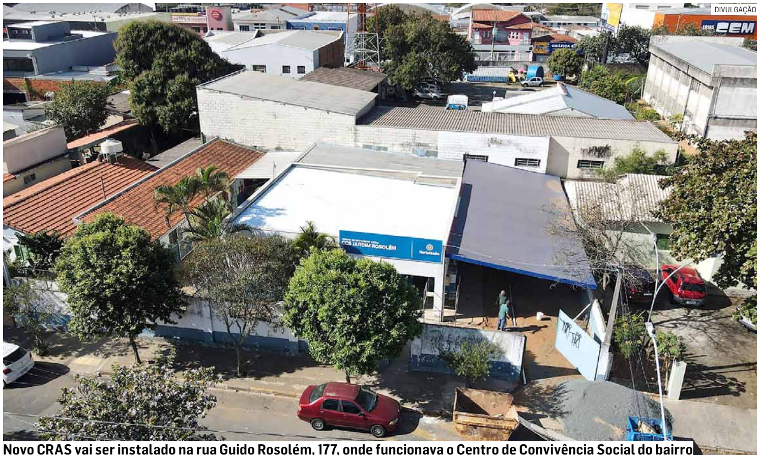
Novo CRAS vai ser instalado na rua Guido Rosolém, 177, onde funcionava o Centro de Convivência Social do bairro
