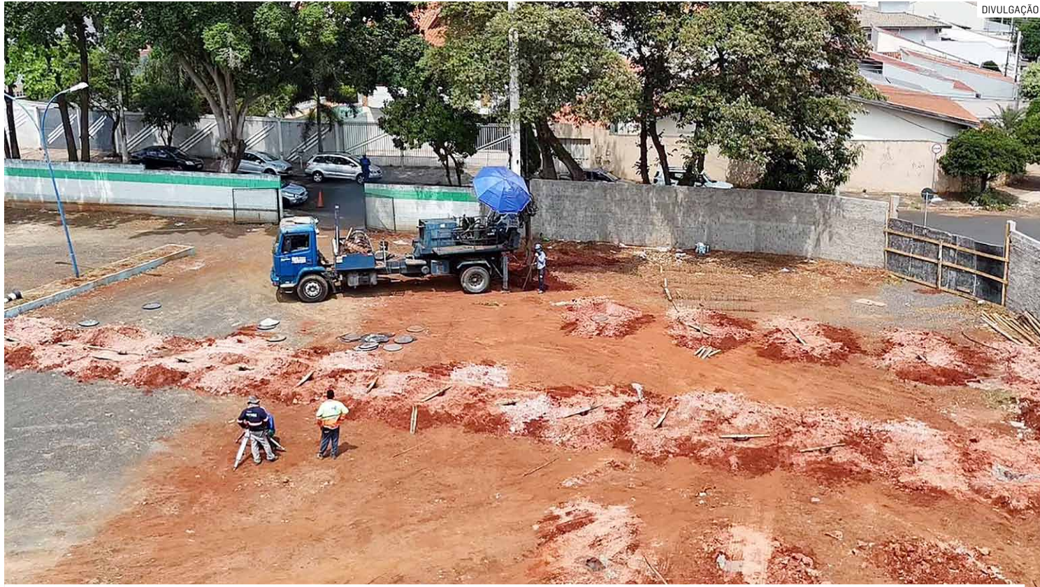
Homens trabalham nas obras de fundação do prédio, que está sendo construído em uma área de 1,3 mil metros quadrados
