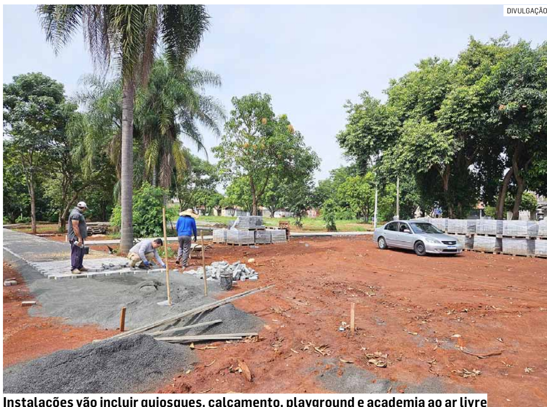
Instalações vão incluir quiosques, calçamento, playground e academia ao ar livre
