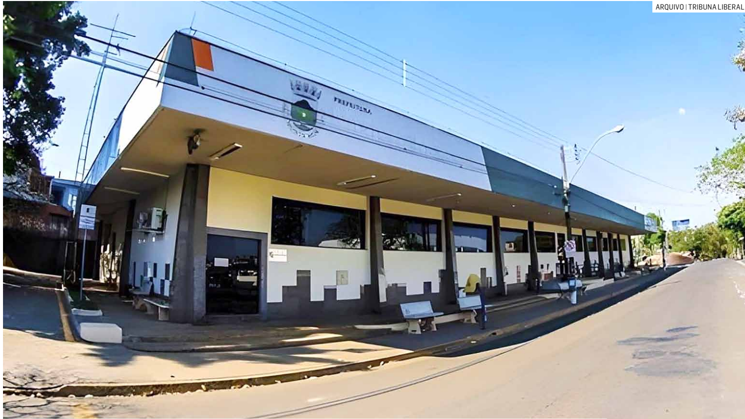
Prefeitura de Monte Mor: medida visa melhorias no traçado e conectividade entre bairros e avenidas
