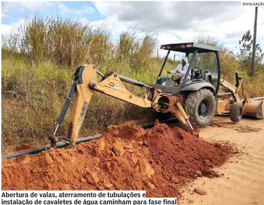
Abertura de valas, aterramento de tubulações e instalação de cavaletes de água caminham para fase final
