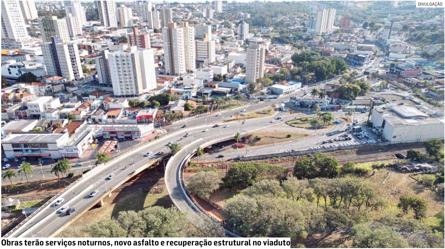
Obras terão serviços noturnos, novo asfalto e recuperação estrutural no viaduto
