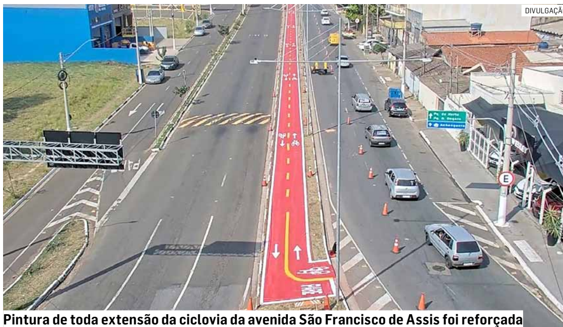
Pintura de toda extensão da ciclovia da avenida São Francisco de Assis foi reforçada
