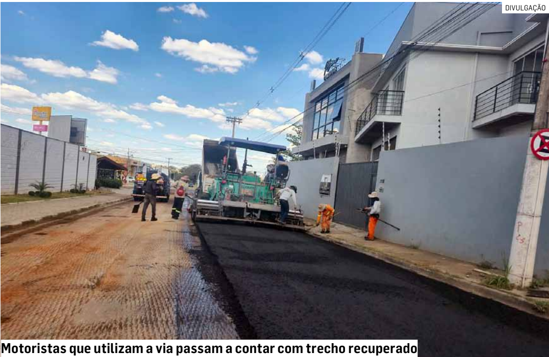
Motoristas que utilizam a via passam a contar com trecho recuperado
