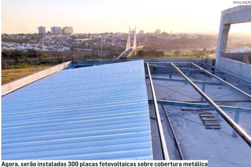
Agora, serão instaladas 300 placas fotovoltaicas sobre cobertura metálica
