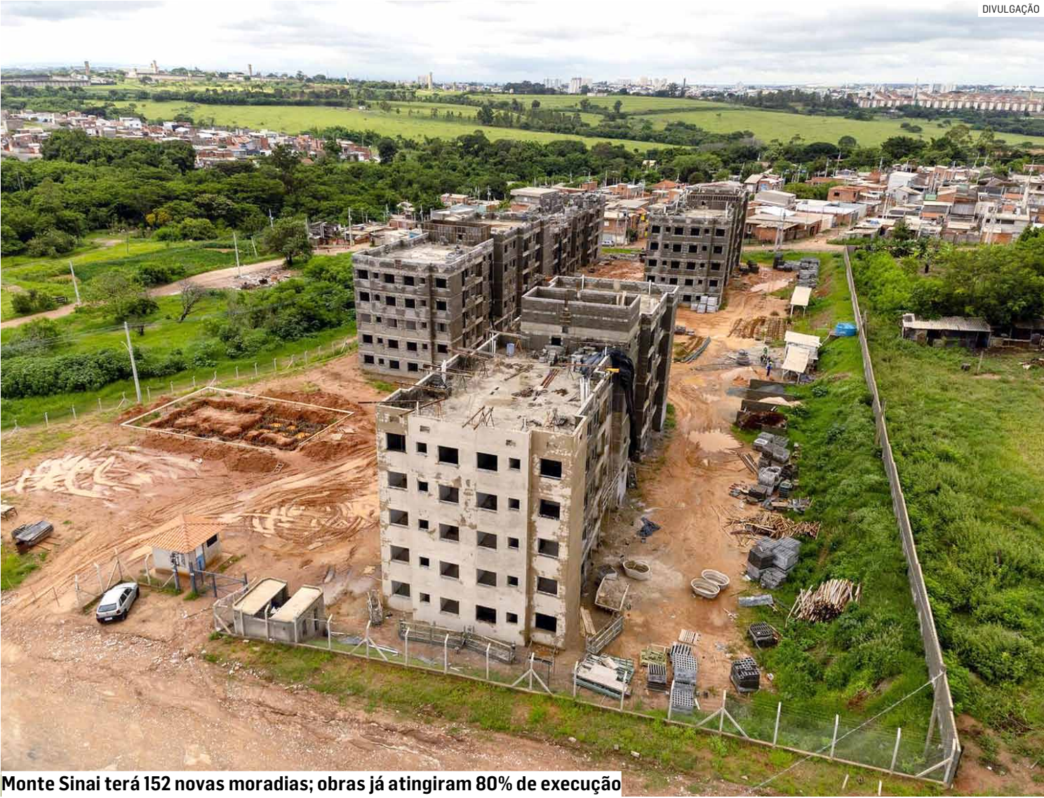
Monte Sinai terá 152 novas moradias; obras já atingiram 80% de execução
