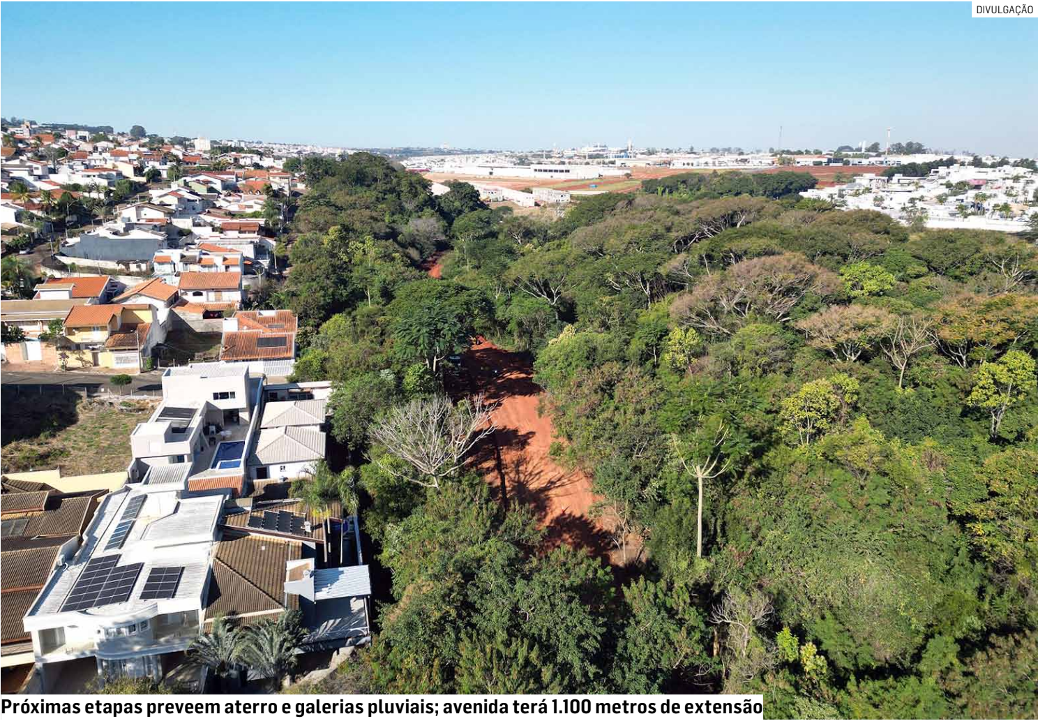
Próximas etapas preveem aterro e galerias pluviais; avenida terá 1.100 metros de extensão
